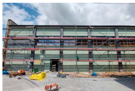
Budowa hali sportowej w Janowicach
